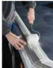
Käytä pehmeää telaa ruuvinkantojen ja pokkausten muotoiluun
