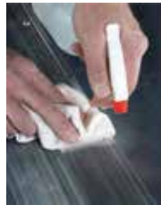
Puhdista pinta veden ja isopropyylialkoholin sekoituksella (50:50)
